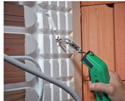
Οι πλάκες πάχους 25 mm τοποθετούνται μεταξύ των πήχεων και στερεώνονται με συγκολλητικό κονίαμα. Η εφαρμογή του συγκολλητικού κονιάματος διασφαλίζει την πλήρη κάλυψη της επένδυσης του τοίχου. Η κατασκευή με πήχεις χρησιμεύει στη στερέωση της επένδυσης τοίχου.
