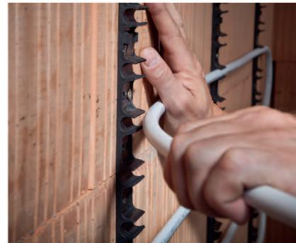
Η επιτοίχια στήριξη πραγματοποιείται με βίδες ή με καρφιά τοίχου. Η αυτοκόλλητη λωρίδα στο πίσω μέρος διευκολύνει την εγκατάσταση με τη στήριξη της ράγας.
